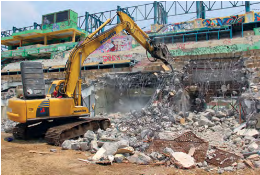
Pembongkaran Stadion Lebak Bulus, September 2015.
