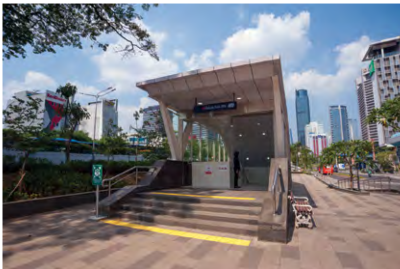
Pintu masuk Stasiun MRT Dukuh Atas BNI (CP106), stasiun bawah tanah terdalam (30 meter) di Fase I, 15 Juli 2019. PT MRT JAKARTA/IRWAN CITRAJAYA.
