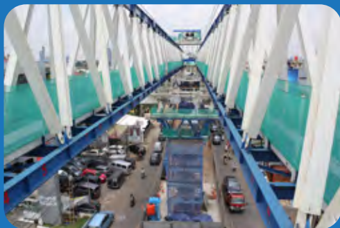
19 Februari 2016 • Koridor MRT di Jalan Fatmawati Mulai Masuk Tahap Konstruksi Pemasangan Gelagar. Dok. PT MRT JAKARTA.
