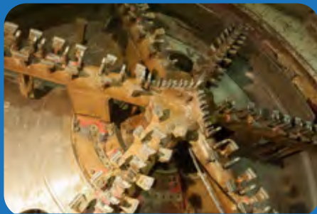
31 Agustus 2015 • Profil Tunnel Boring Machine (TBM). PT MRT JAKARTA/IRWAN CITRAJAYA.
