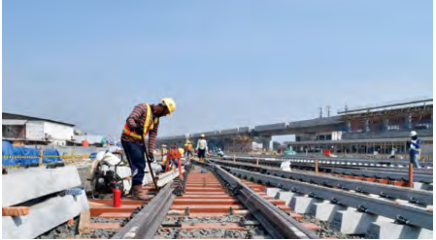
Pengerjaan pemasangan rel di Depo MRT Lebak Bulus. PT MRT JAKARTA/NASRULLAH.
