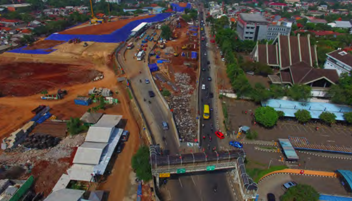
Suasana Pembangunan Depo MRT Lebak Bulus. Dok. PT MRT JAKARTA.
